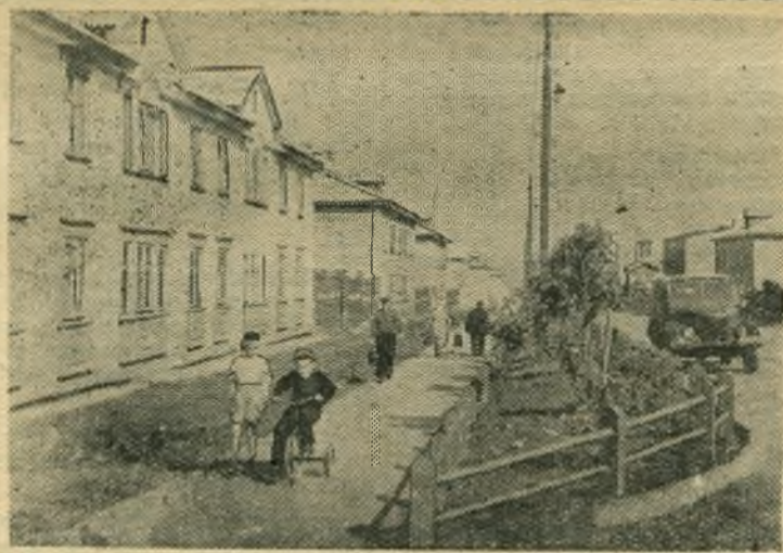
Иркутск. На улице Мухина в поселке строителей Иркутской ГЭС. Фото В. Мастонова и А. Софийского. (Фотохроника ТАСС).
