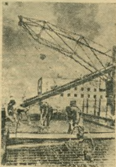
Гсмельская область. В поселке Шатилки сооружается одна из крупнейших в республике Васильевская ГРЭС.
