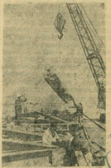
Казань. С пуском Куйбышевской ГЭС уровень Волги в районе Казани поднимется и затопит существующие причалы. Сейчас строится новый речной порт. Сооружены волнолом, 1000-метровая металлическая причальная стена. Строятся защитные дамбы и подъездные пути. Монтажные приступили к сборке мощных электрических подъемных кранов.
