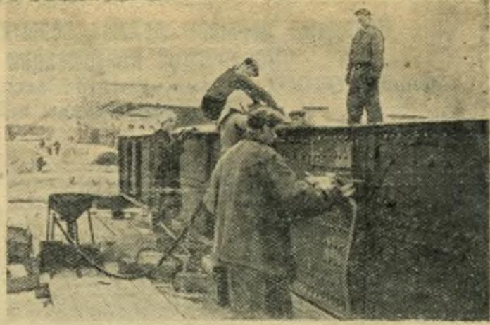
Идут работы по реконструкции моста через Крымзу. НА СНИМКЕ: монтаж фермы нового моста.
