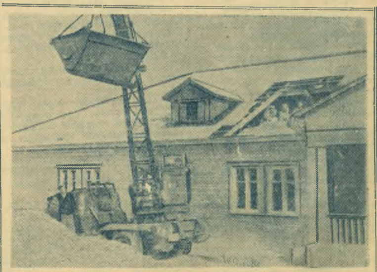
В поселке строителей завода кузнечно-прессового оборудования. НА СНИМКЕ: комплексная бригада тов. Бахарева производит засыпку шлаковатой потолка строящегося дома. Фото Ф. Шнарбаненко.
