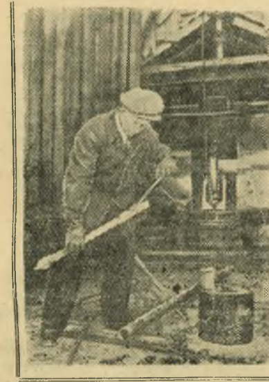
Оха. Остров Сахалин пока является основным источником нефти на Дальнем Востоке. Несмотря на его отдаленность от основных промышленных центров страны, разведка и эксплуатация нефтяных месторождений здесь осуществляется с применением последних достижений науки, используется обширный комплекс геофизических исследований. Разведка нефтеносных и газовых пластов ведется с помощью теллурических токов, радиоактивного и газового каротажана. Радиоактивный каротаж является одной из областей, где энергия распада тяжелых элементов используется в мирных целях. НА СНИМКЕ: начальник партии радиоактивного каротажника Л. Г. Абрамов закладывает нейтронный источник в глубинный прибор перед спуском в скважину для исследования нефтяных пластов. Фото Н. Назарова. (Фотохроника ТАСС).
