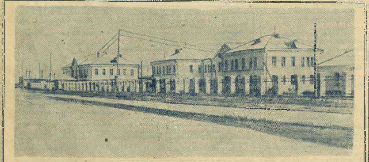
Второй строительный участок треста № 112 закончил основные работы по сооружению больничного комплекса для гидротурбинного завода. Сейчас завершаются отделочные работы. В больничном комплексе входят: поликлиника, главный корпус больницы, здания родильного отделения, инфекционного отделения, гараж, прачечная. НА СНИМКЕ: общий вид больничного комплекса. Фото Г. Калмыкова.
