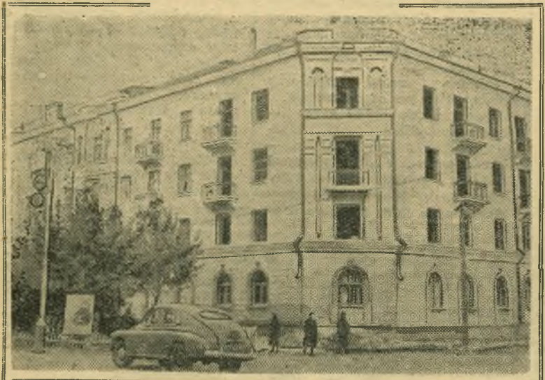
Заканчивается строительство многоквартирного дома для железнодорожников на Московской улице. НА СНИМКЕ: вид дома с угла. Фото В. Жукова.
