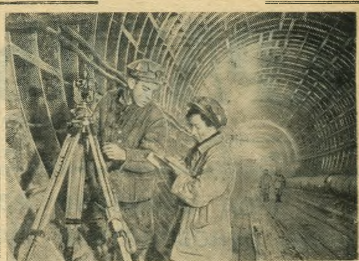
Строительство 5-й очереди Московского метрополитена имени В. И. Ленина. НА СНИМКЕ: маркшейдеры В. Кабанов и А. Кохтенко за нивелировкой подходного тоннеля к станции «Всесоюзная сельскохозяйственная выставка». Фото Л. Великанкина. (Фотохроника ТАСС).
