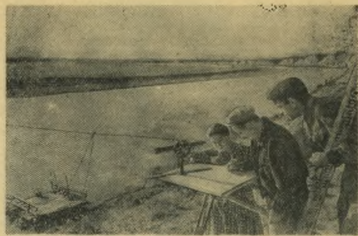
Азербайджанская ССР. Директивами XX съезда КПСС предусмотрено начать строительство гидроэлектростанции на реке Куре. Сейчас здесь идут геологические и топографические работы.
