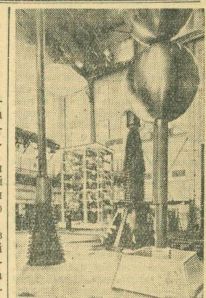
**Москва.** Испытательная станция — один из важнейших участков производства на заводе «Изолитор». Здесь испытываются все крупногабаритные маслонаполненные изоляторы, выпускаемые заводом, а также проверяются разрабатываемые вводы и изоляторы высокого напряжения (от 110 до 400 киловольт) для линий электропередач и трансформаторов строящихся гидроэлектростанций, ведутся исследовательские работы по определению электрической прочности высоковольтных изоляторов.
