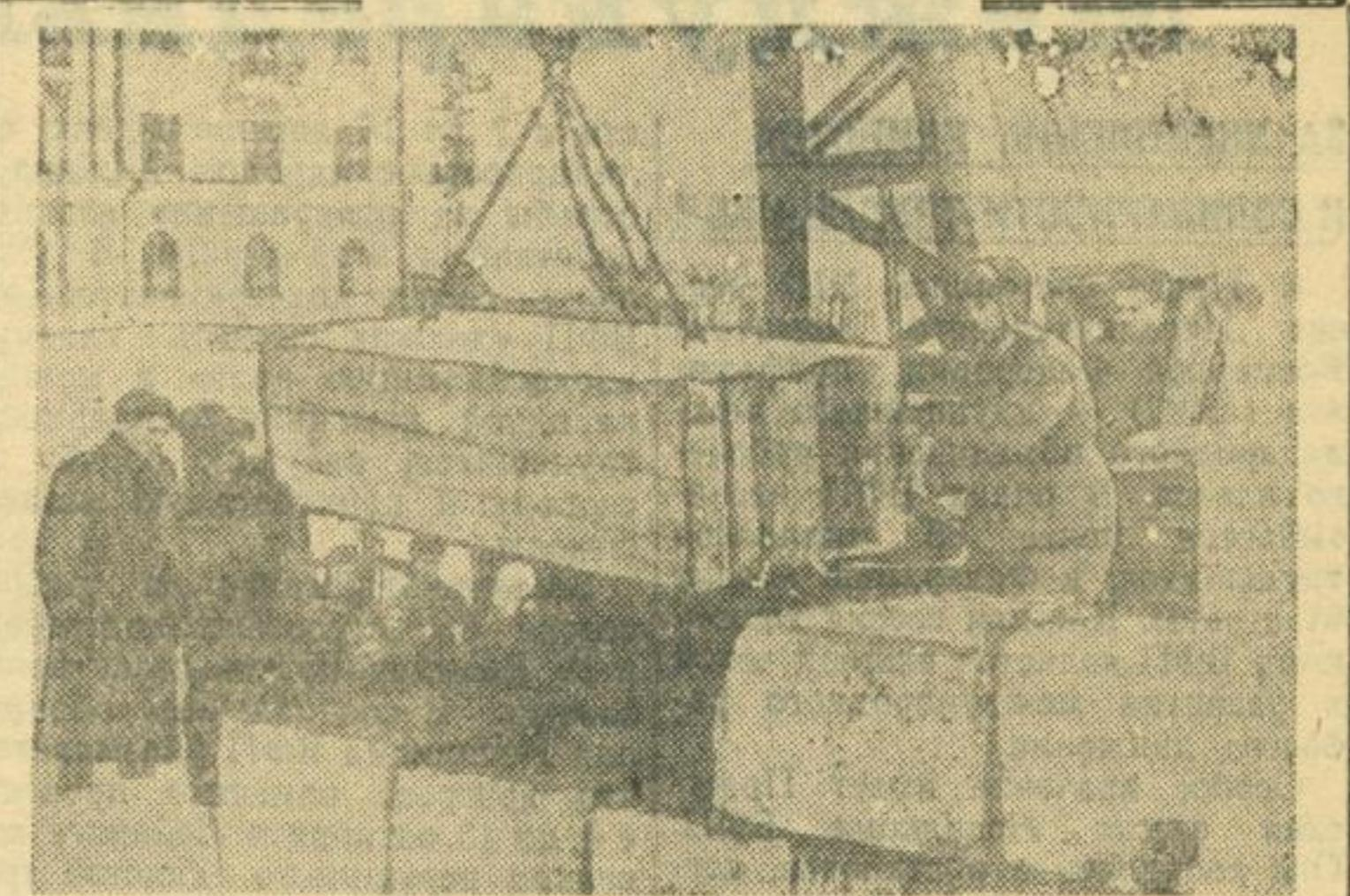
На углу улиц Московской и Фридриха Энгельса ведется строительство 96-ти квартирного дома для комбайностроителей. Кладку фундаментов и стен подвала ведет бригада монтажников тов. Шушпанова В. П. (трест № 112). НА СНИМКЕ: кладка стен подвала из крупных блоков. Фото Г. Калмыкова.
