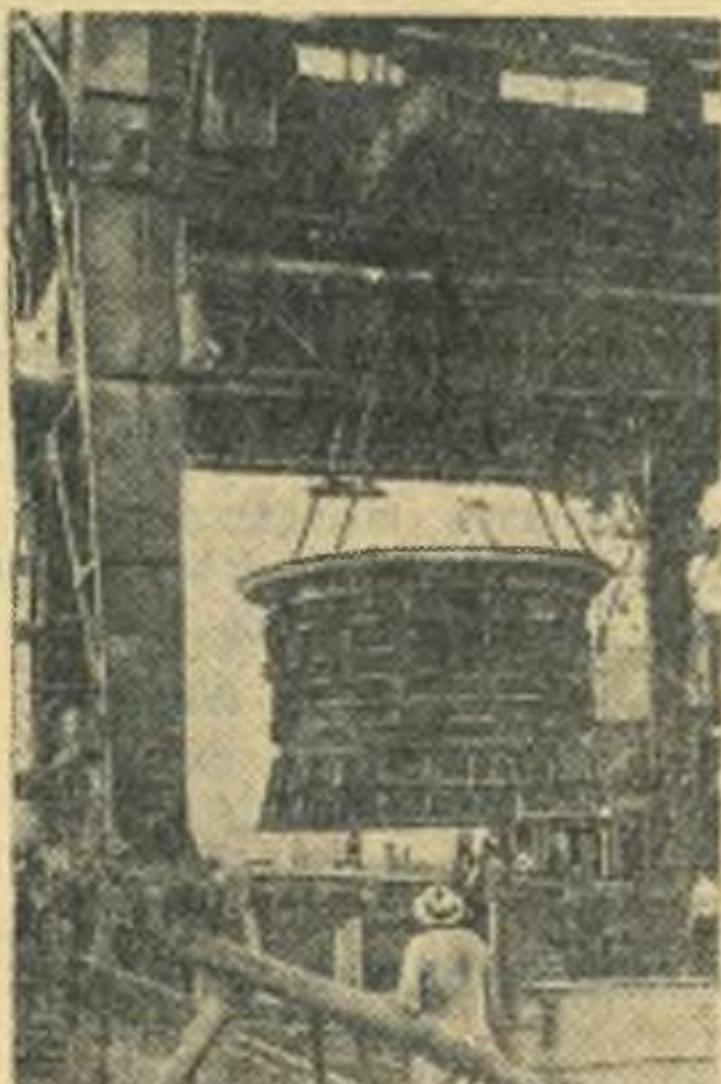
Таджикская ССР. На строительстве Кайрак-Кумской гидроэлектростанции «Дружба народов» развернулись строительно-монтажные работы на четвертом агрегате. Он войдет в строй действующих в августе этого года. Сейчас монтажники ведут сборку узлов агрегата. В турбинном зале установлен статор турбины. На днях была опущена камера рабочего колеса турбины четвертого агрегата.
