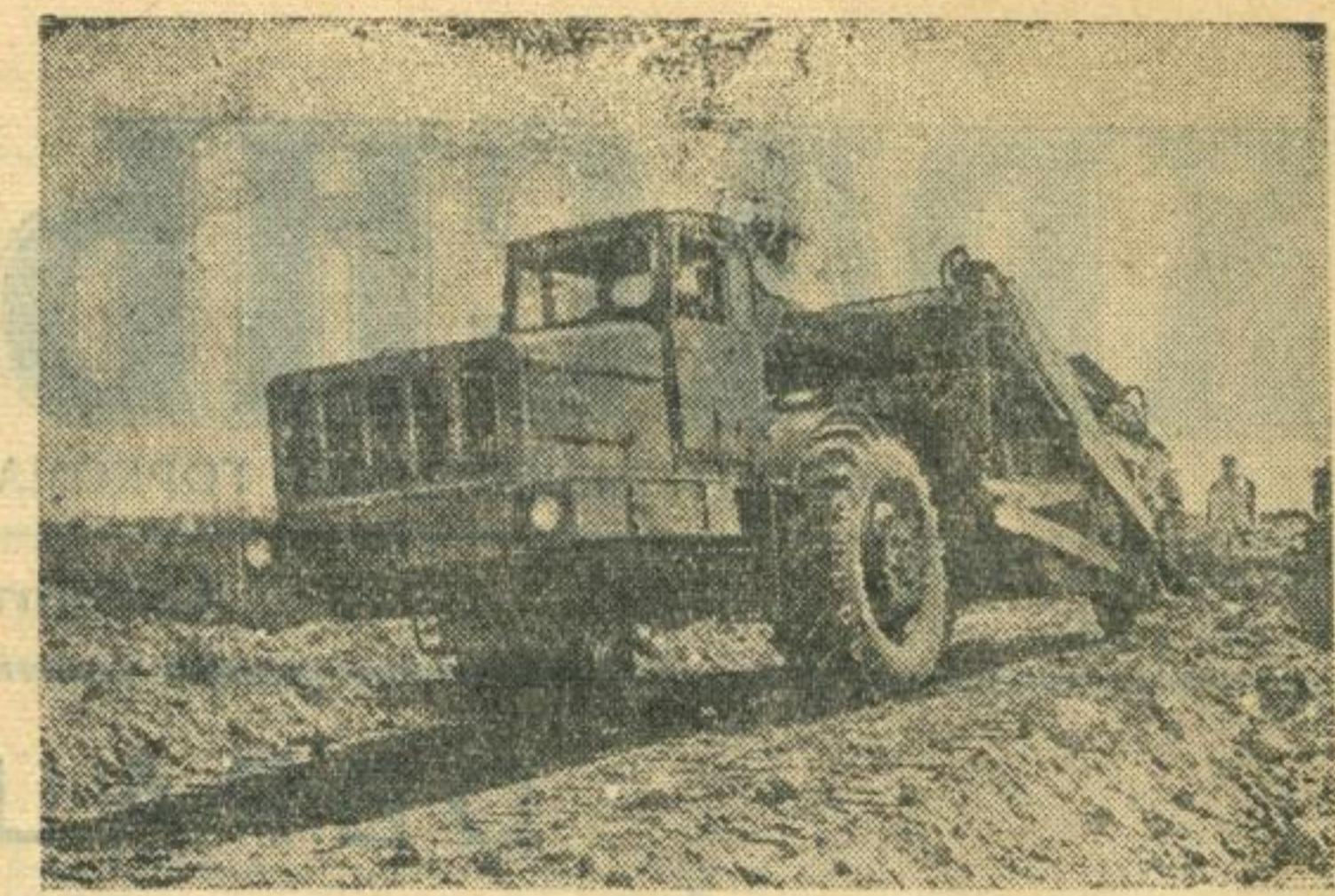
Украинская ССР. На николаевском заводе «Дормашин» построен самоходный скрепер «Д357Г» на базе нового минского автомобиля — тягала «МАЗ-529». Ковш скрепера емкостью II кубометров имеет ширину захвата грунта 2,78 метра.
