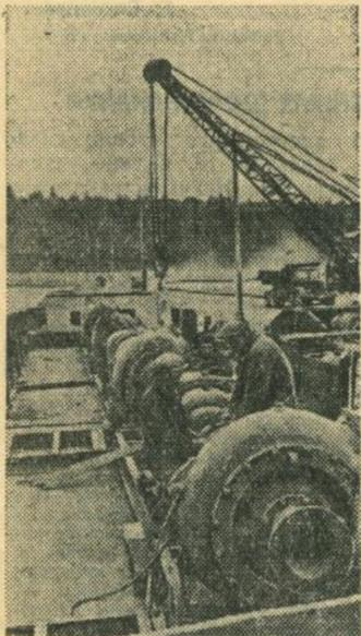
НА СНИМКЕ: монтаж насосов на одной из барж в котловане будущей ГЭС.
